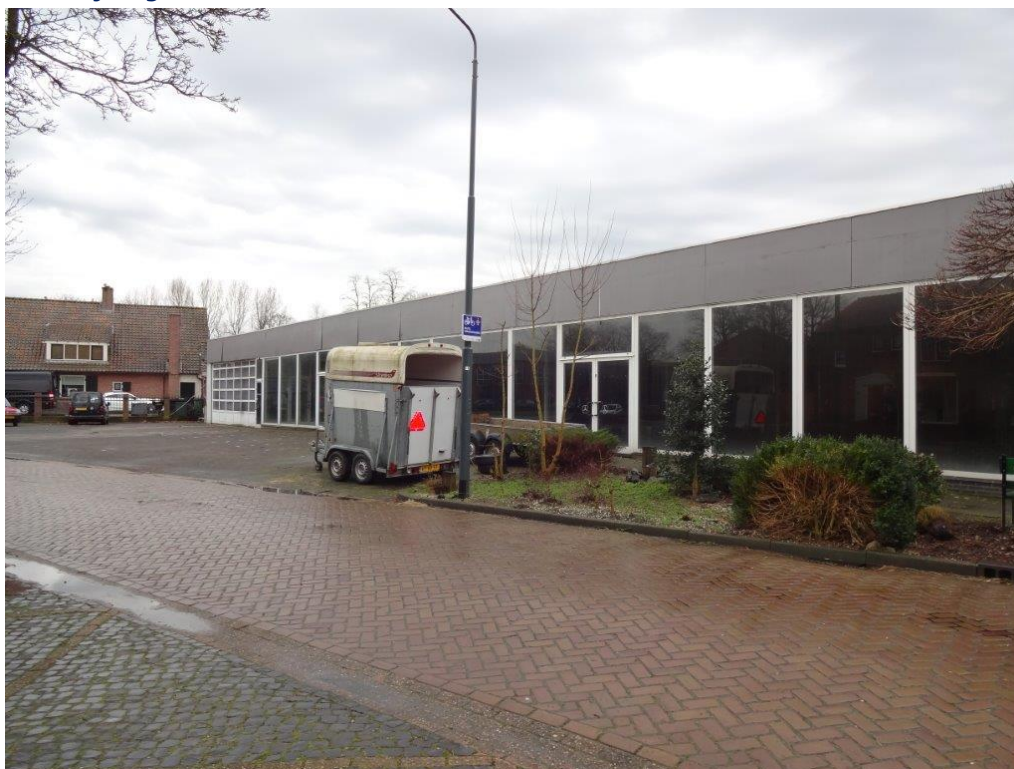
Oostelijke gevel vanuit het noordoosten:
