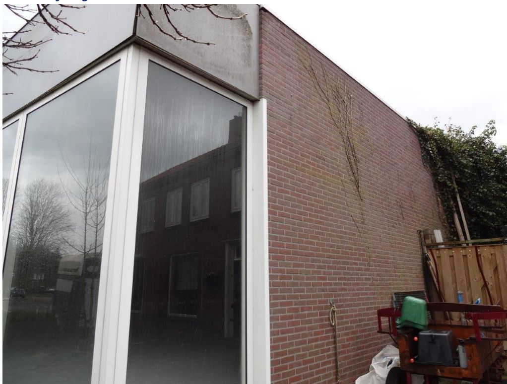
Noordelijke gevel vanuit het noordoosten:
