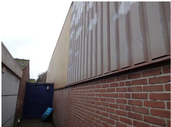
Westelijke gevel vanuit het brandpad achter het pand:
