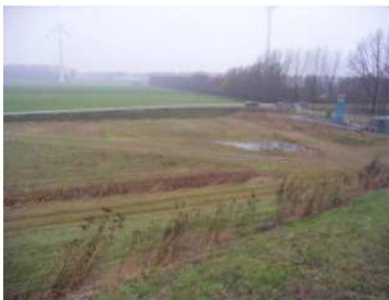
Bestaande fakkel installatie
