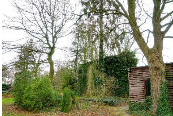
Achterzijde centrale werkloods
