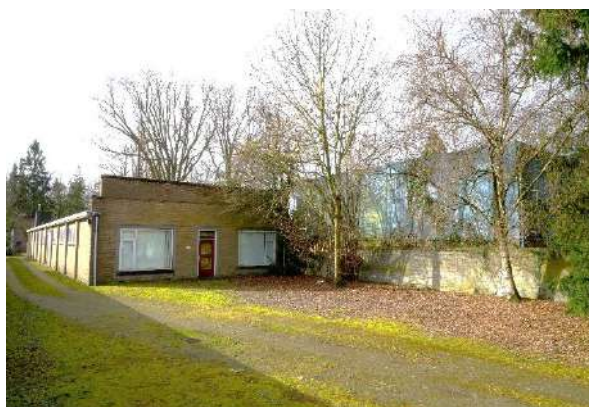
Werkloods in noordelijk deel
