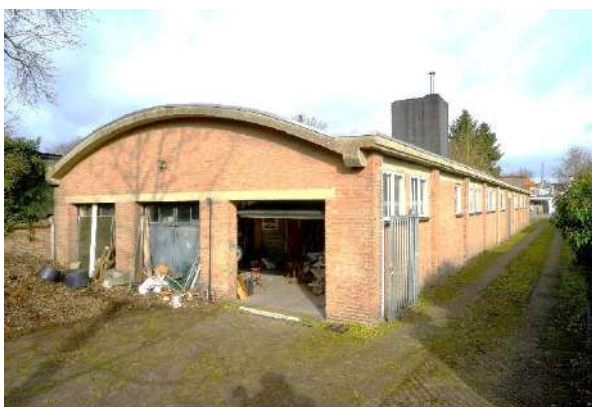
Werkloods in noordelijk deel
