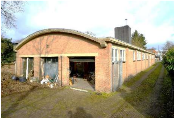
Werkloods in noordelijk deel
