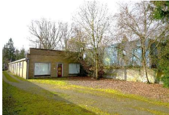
Werkloods in noordelijk deel
