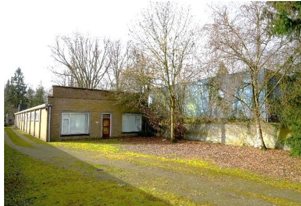
Werkloods in noordelijk deel
