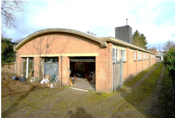
Werkloods in noordelijk deel
