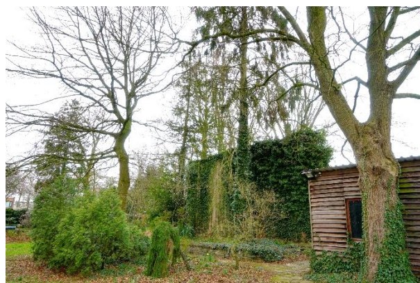
Achterzijde centrale werkloods
