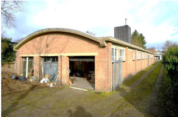
Werkloods in noordelijk deel
