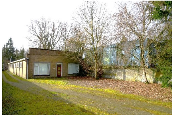
Werkloods in noordelijk deel
