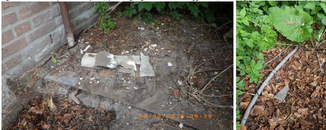
Figuur 2.7: Asbest op maaiveld (links op naastgelegen locatie scoutinggebouw, rechts t.p.v. onderzoekslocatie)
