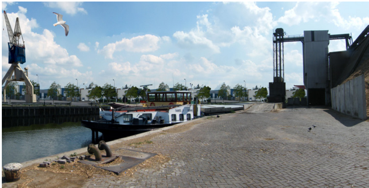
Uitbreiding aan de oostzijde van het water
