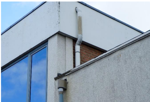
Detailfoto van openingen in de gevel
