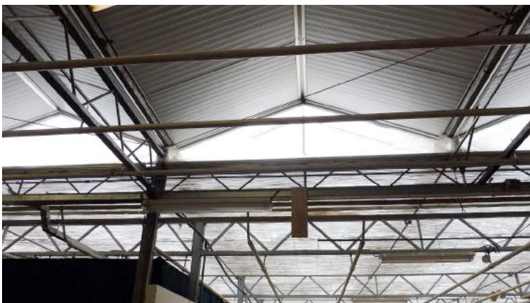
Afbeelding 10: Dakconstructie aan de binnenzijde van het tuincentrum, dit type dak is ongeschikt voor vleermuizen.
