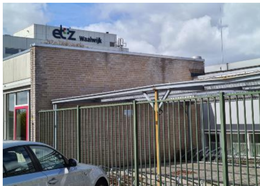
Figuur 8: Zuidzijde bebouwing met openstootvoeren
