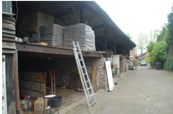
De te slopen loods
