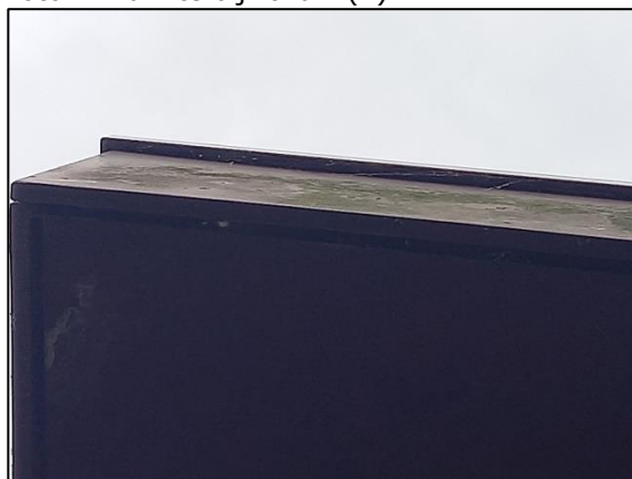
Foto F: ruimte onder metalen daklijst (4)
