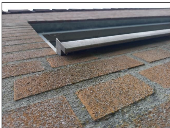
Foto I: ruimte onder de vensterbank (7)
