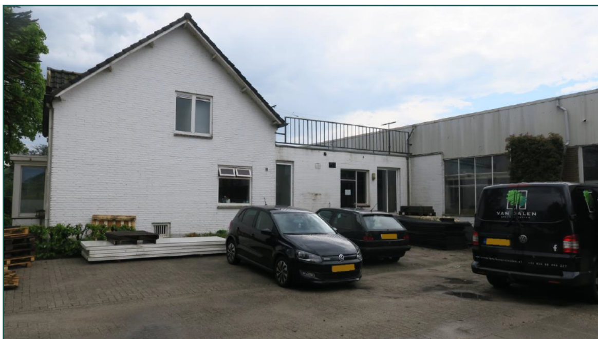
Figuur 2 De woning welke behouden blijft.
