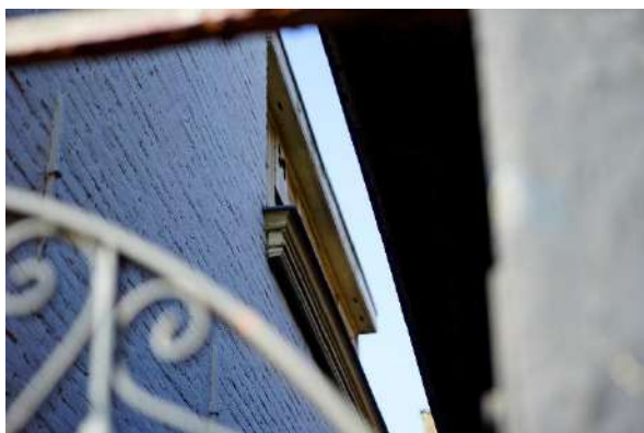
Close-up van de dakrand.
