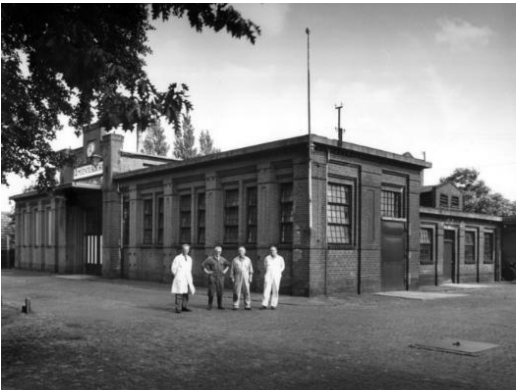
Figuur 2.1 Het voormalige Slachthuis aan de Sint Antoniusstraat in Waalwijk, met op de voorgrond enkele werknemers. © A. Oudkerk/auteursrecht G.CM Verheijen/SALHA
