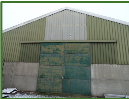
Afbeelding 24: Voorgevel stal, damwand en betonnen wanden
