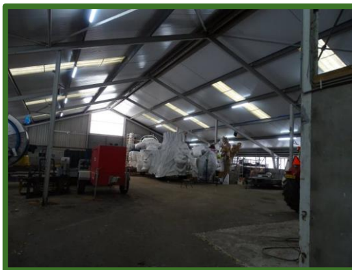
Afbeelding 13 en 14: Binnenzijde voormalige melkveestal in gebruik als opslag, dak met stalen spanten en een ondergrond van beton
