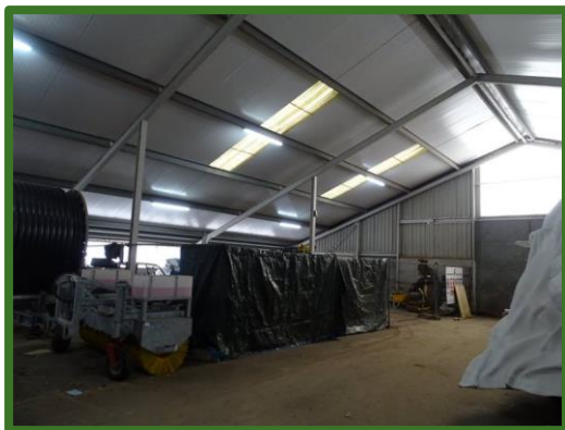
Afbeelding 13 en 14: Binnenzijde voormalige melkveestal in gebruik als opslag, dak met stalen spanten en een ondergrond van beton
