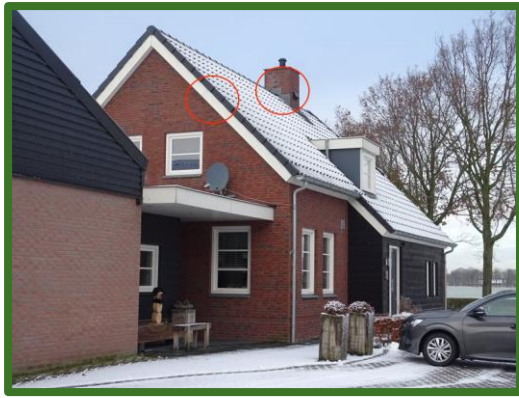
Afbeelding 19: In rood omcirkeld; loodslabben en overhangende dakpannen aan de zijgevels, met een glad boeiboord
