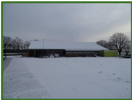
Afbeelding 3: Uitzicht op bedrijfsgebouw en loods vanuit het zuiden
