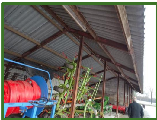
Afbeelding 5: Binnenzijde half open loods, in gebruik als opslag
