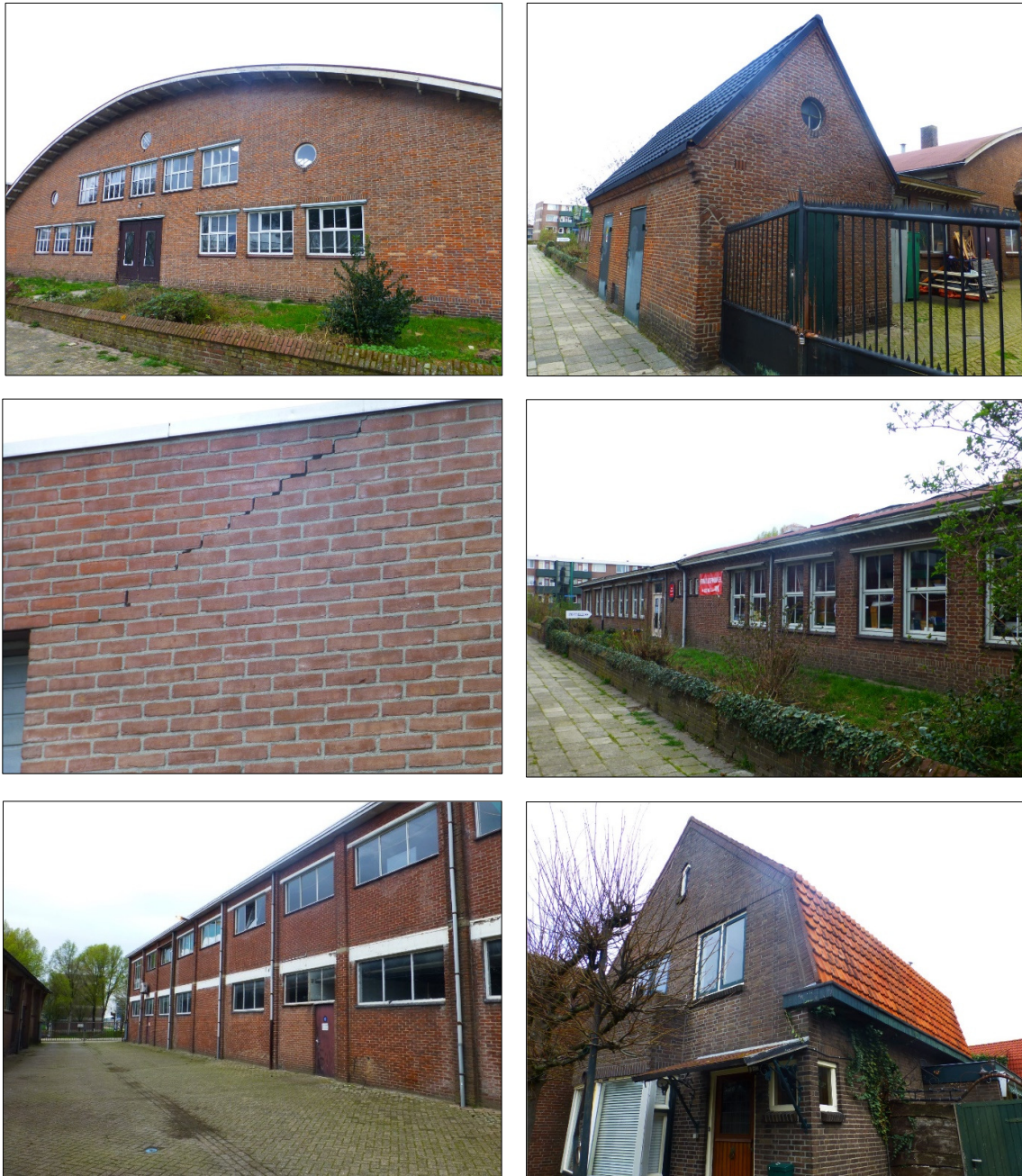
Figuur 2 - 7: Impressie van het plangebied met een van de twee karakteristieke hallen, trafohuisje, verzakt gebouw, zicht op industriële gebouwen en een woonhuis.
