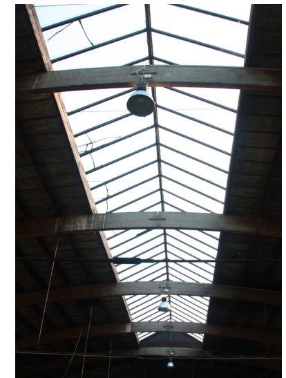
De lichtstraat in industriehal 2 is, vanwege de koppel-/ verbindingsstukken in het midden, anders geconstrueerd dan die in hal 1.
