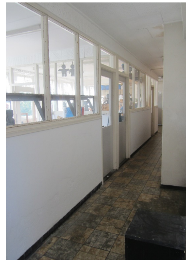
De gang met kantoren in de aanbouw tegen de rechter zijgevel van industriehal 1.
