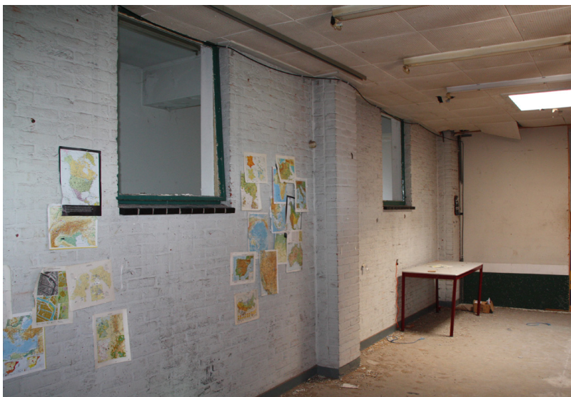
De voormalige buitengevel is na de verbouwing van 1961 een binnenwand geworden.
