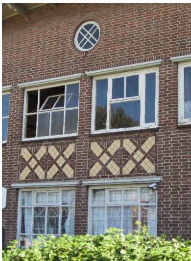
vensters en metselwerk ornamentiek (hal 1)
