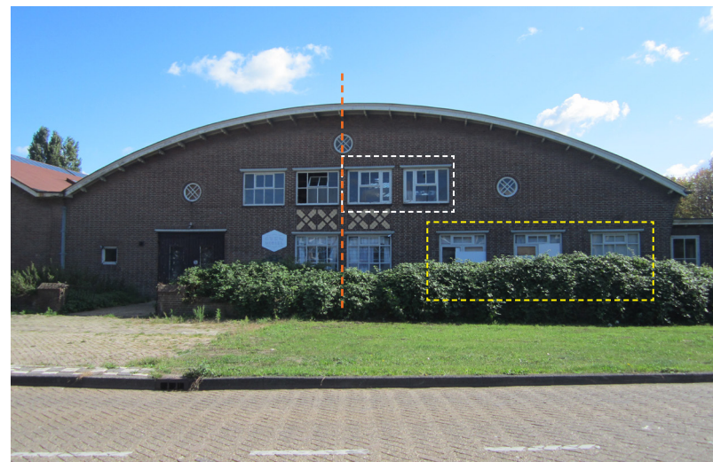
Voorgevel van industriehal 1. Geel omkaderd: aangepaste gevelindeling. Wit omkaderd: aangepaste ramen en raamindeling. Oranje: symmetrie-as
