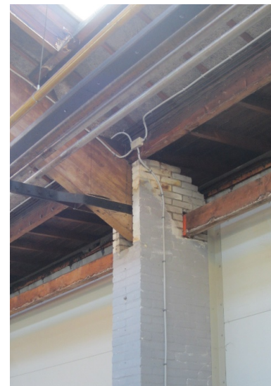
Aansluiting spant en kolom. Op de kolom ligt de zakgoot tussen de industriehallen.
