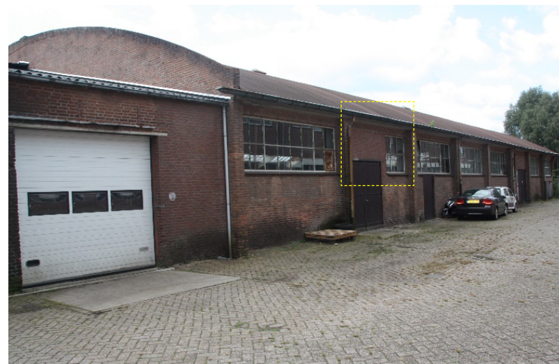
De zijgevel van industriehal 2 en de aanbouw tegen de achterzijde vormen de linker zijgevel. Geel kader: aanpassing van de gevelindeling.
