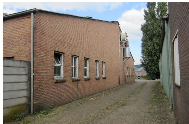
De achtergevel van de aanbouw achter industriehal 2.
