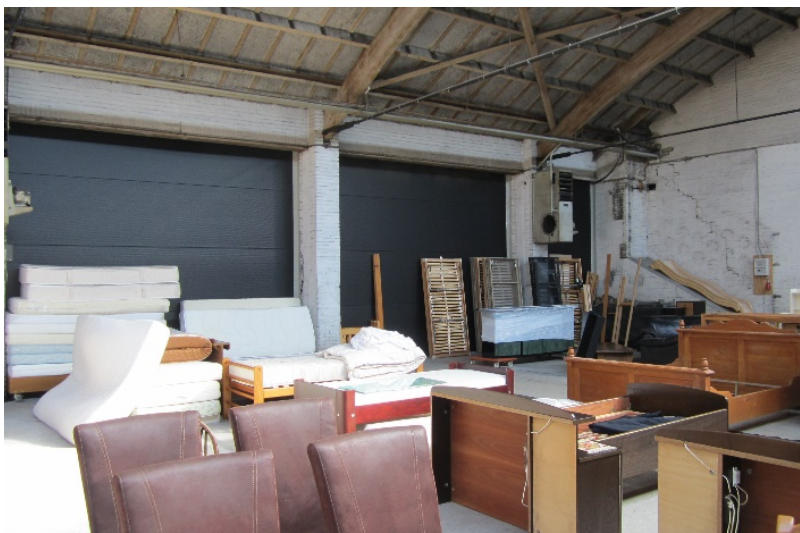
De voormalige gevel tussen industriehal 1 en 2 is dichtgezet met roldeuren. Boven deze deuren zijn nog sporen zichtbaar van de dichtgezette vensters in deze gevel, gezien vanuit hal 1.
