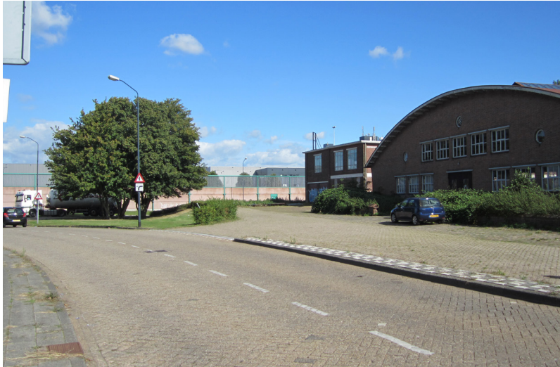
Industriehallen langs de Zomerdijksestoep, fabrieksgebouw langs de Taxandriaweg. Voor beide is een bouwhistorische quickscan uitgevoerd. Zie hoofdstuk 4.
