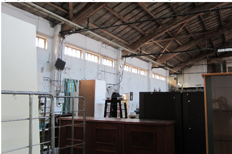
In de rechter zijgevel van industriehal 1 bevinden zich hoog geplaatste langwerpige vensters.
