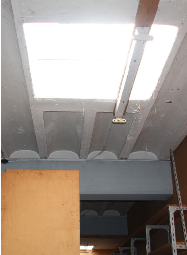
Geïntegreerd daklicht in het daksysteem.
