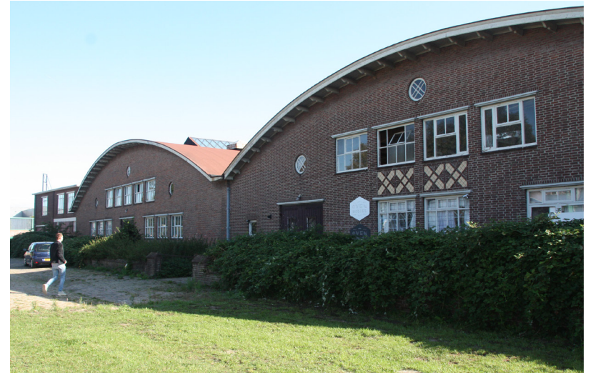
Industriehallen langs de voormalige Zomerdijkweg.
