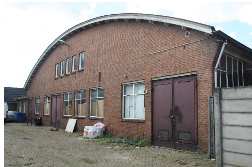
De achterzijde van industriehal 1 is in 1966 verlengd.
