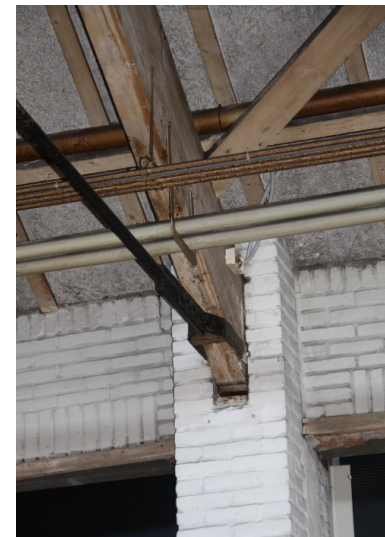
De houten Nemahospanten met trekstangen rusten op de metselwerk penanten
