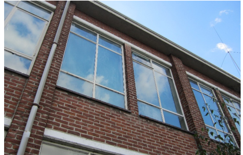
Vensters in de voorgevel.
