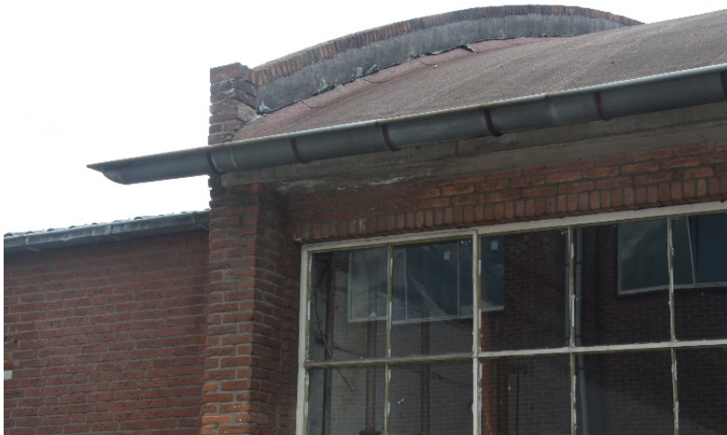
Op de foto de verhoging van het dak van de achtergevel.
