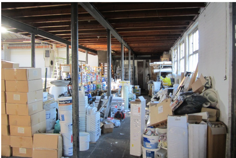
De verdieping wordt ondersteund door slanke metalen kolommen die in 1959 zijn geleverd en geplaatst door de stalen veren industrie. (hal 2)
