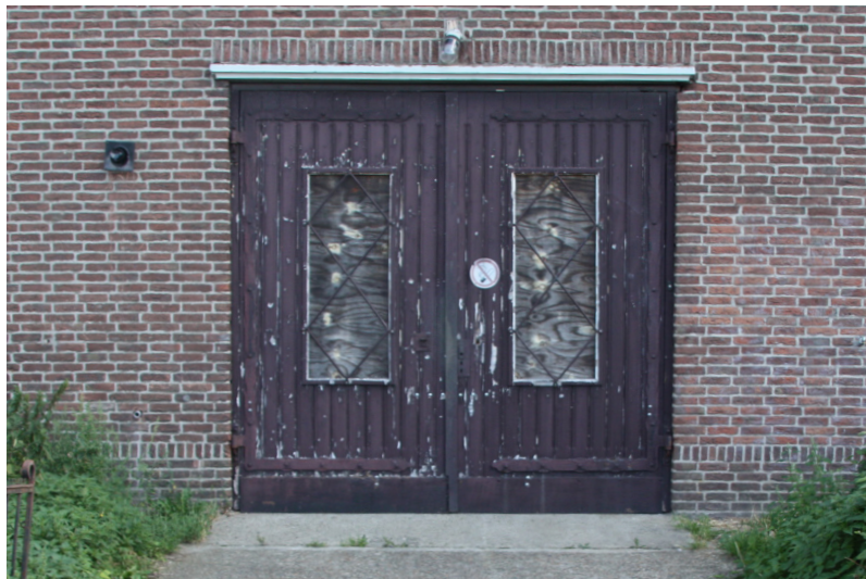
De deuren van industriehal 1 en 2 zijn hetzelfde uitgevoerd
