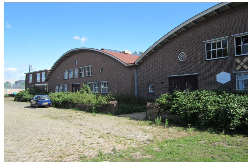
Voorgevel aan de voormalige Zomerdijkweg.
