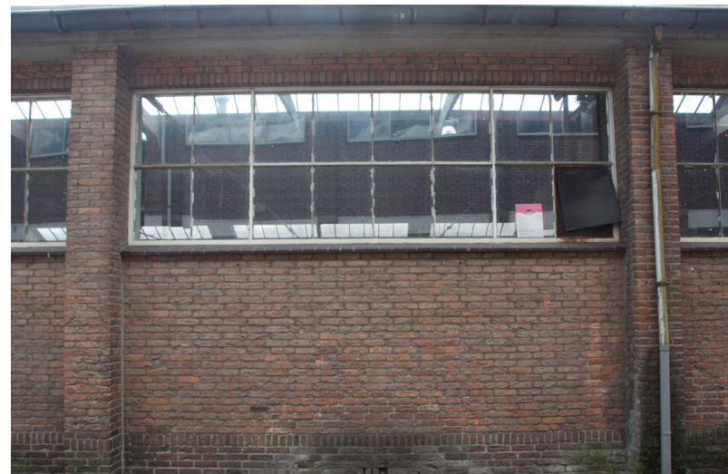
Oorspronkelijke gevelindeling en venster met stalen ramen.
