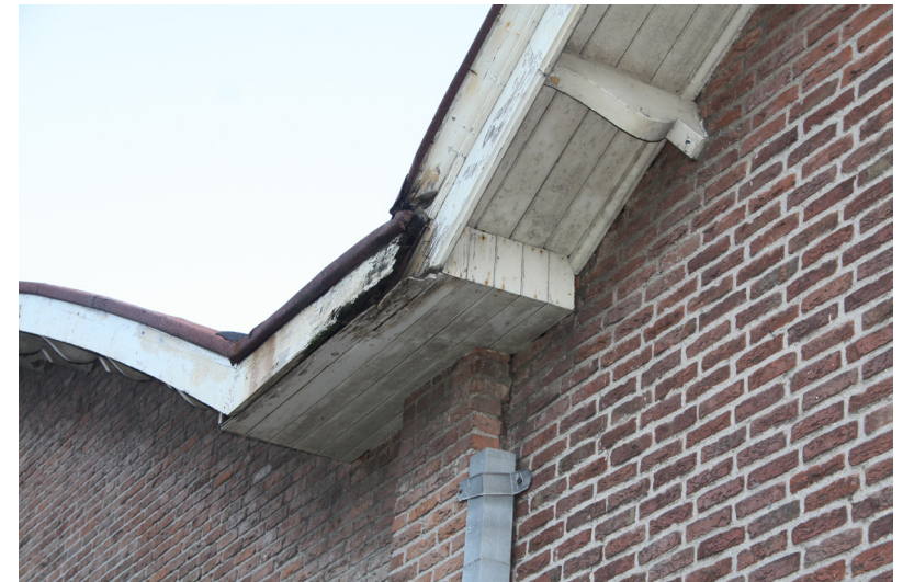
Zakgoot tussen de industriehallen.
