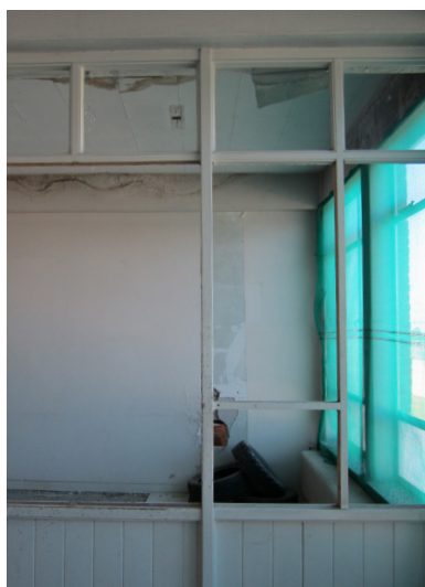
Originele scheidingswand op de verdieping.
