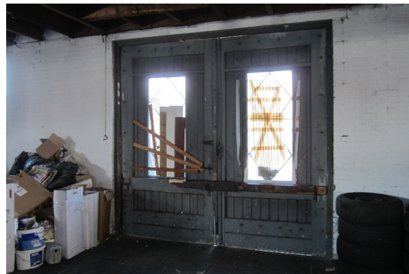
De deur in de voorgevel gezien van binnenuit. (hal 2)
