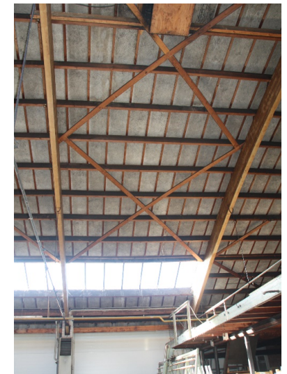
Ook de windverbanden en gordingen zijn uitgevoerd in hout.
