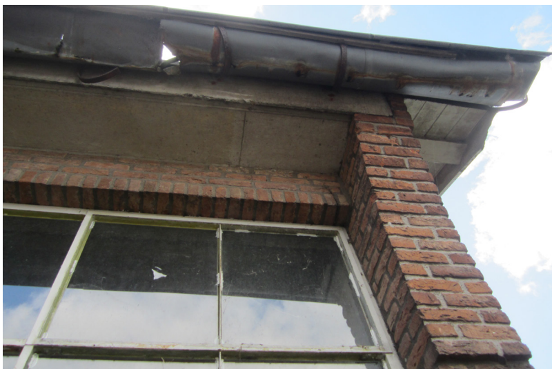
Aansluiting voorgevel met schouderstuk, zijgevel en goot.
