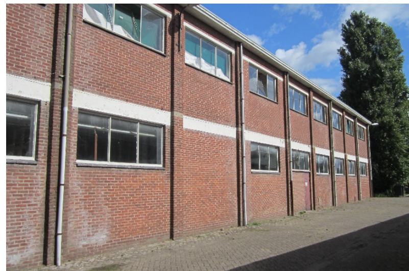
Achtergevel, in het midden ontbreekt een vensterstrook, daarachter was een trap en lift.
