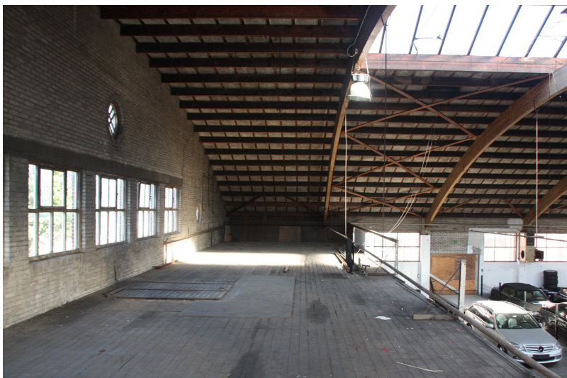
De verdieping aan de voorzijde van hal 2.
