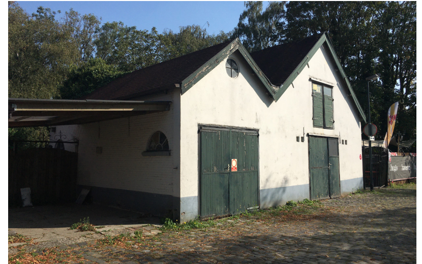
Stenen pakhuis, dit maakte onderdeel uit van een rij houten pakhuizen. Voor dit gebouw is een bouwhistorische quickscan uitgevoerd. Zie hoofdstuk 4.
