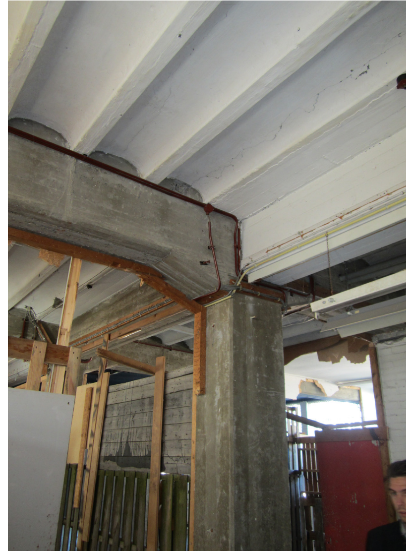
De betonconstructie met de verdiepingsvloer van segmentvloer elementen.
