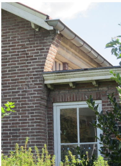
voorgevel met schouderstuk, aansluiting met de aanbouw (hal 1)
