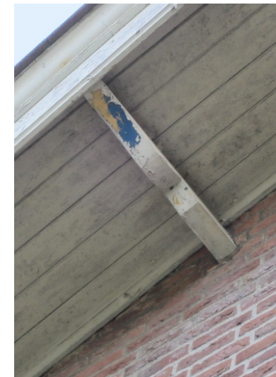
Dakoverstek, op de klossen zijn onder de huidige verflaag meerdere kleurtinten zichtbaar. (hal 1)
