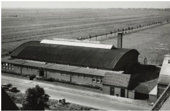
Foto van de eerste industriehal, 1953 (bron: beeldbank SALHA)
