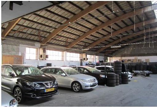
Tweede industriehal spanten zichtbaar binnen
