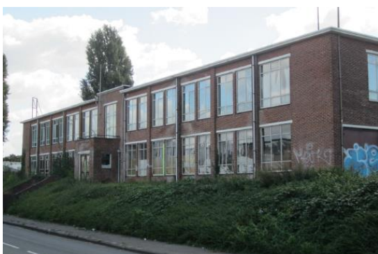
Fabrieksgebouw aan de Taxandriaweg 2
