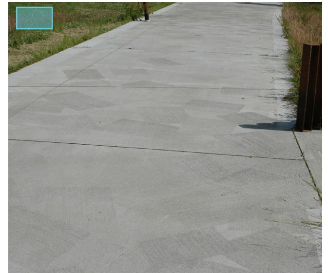
In het werk gestort beton met geveegde afwerking
