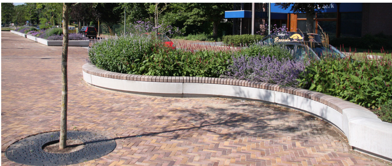
De plantenborders bij het Larixplein worden voorzien van een zitrand met op enkele plaatsen een zitvlak van hout
