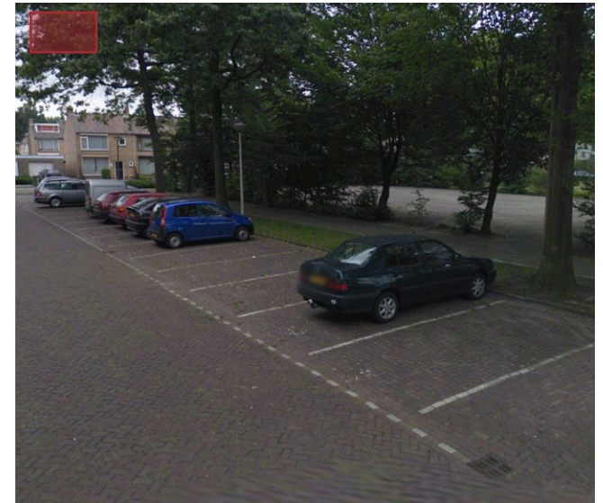
Hergebruik gebakken klinkers, elleboogverband
