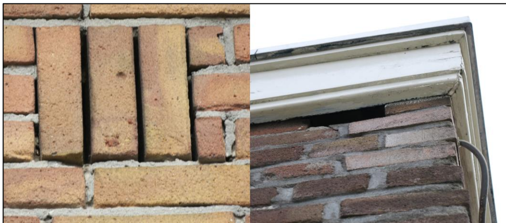
Figuur 4 In de bebouwing zijn ventilatioeroosters en openingen onder het overstek aanwezig.
