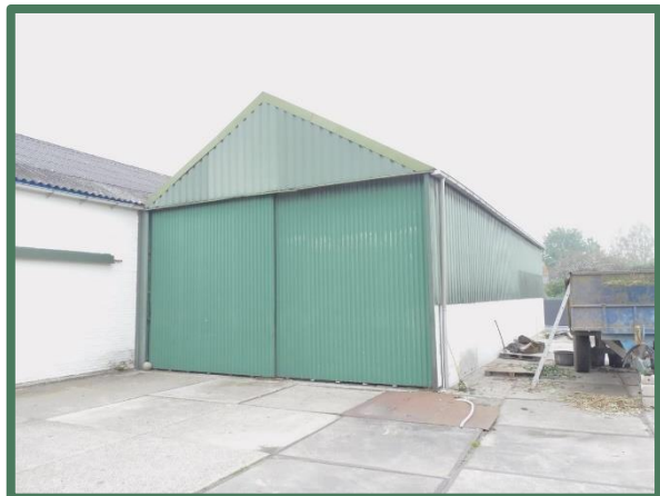
Overzicht zuidzijde loods
