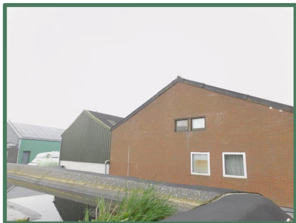
Overzicht noordzijde laboratorium en loods
