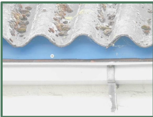
Vogelschroot onder golfplaten dak laboratorium
