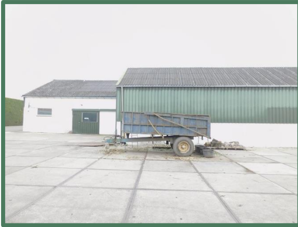
Overzicht oostzijde loods en laboratorium
