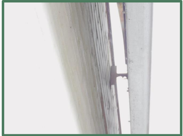
Ruimte tussen de bakstenen wand en damwand verfraaiing
