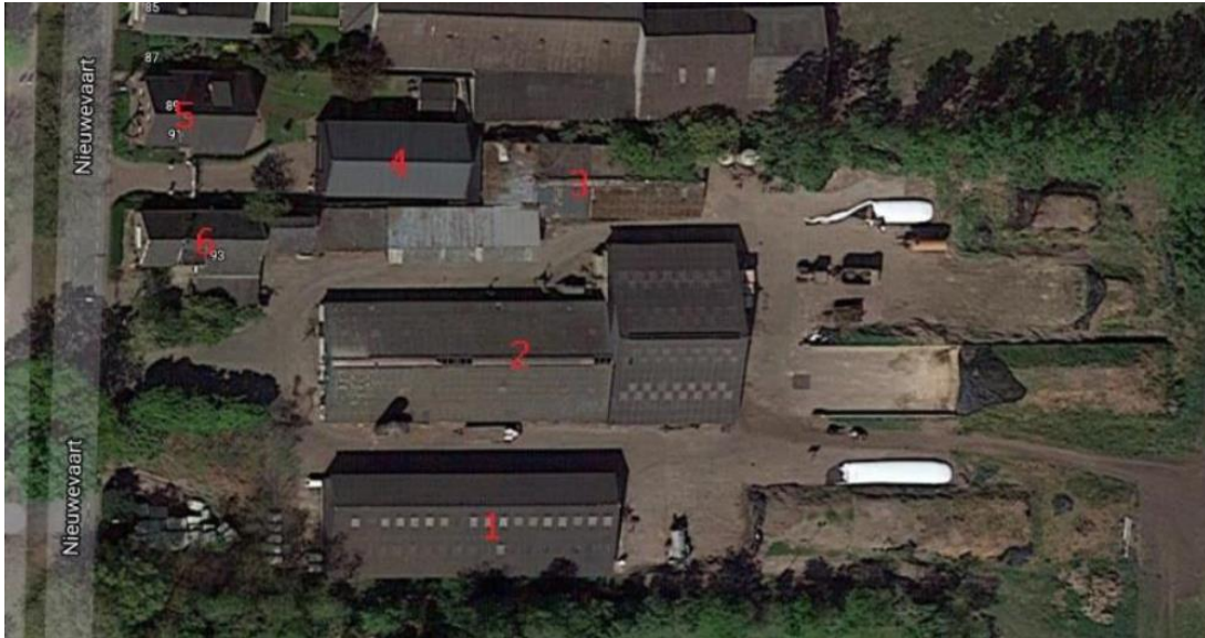
Bedrijfswoningen en agrarische bedrijfsgebouwen
