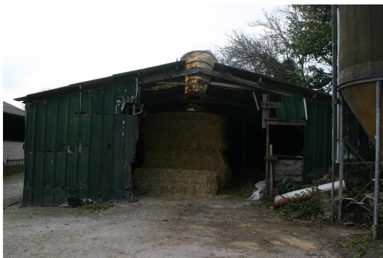
Figuur 4.4.3. De stro-opslag.
