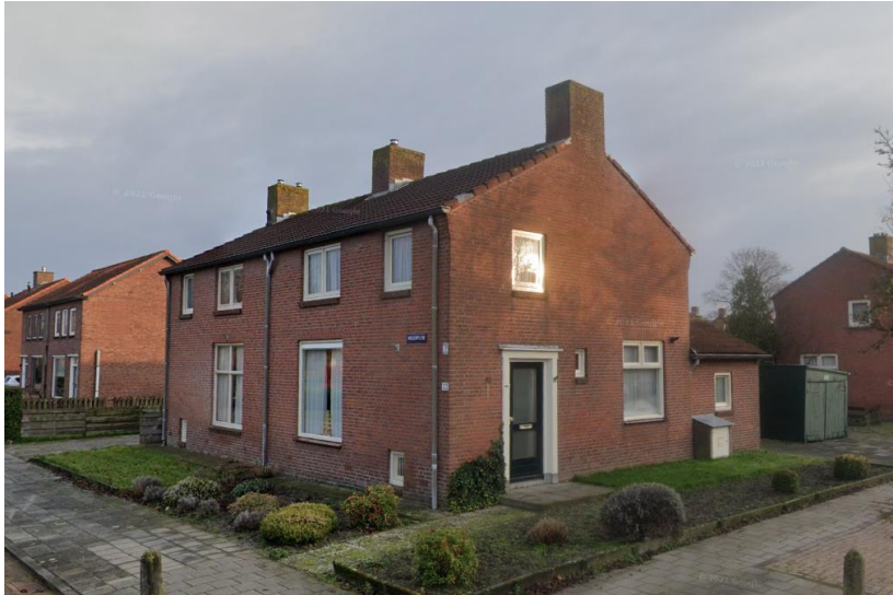
Twee-onder-een-kapwoningen Molenplein 18 en 20 (google Street view, 2021)
