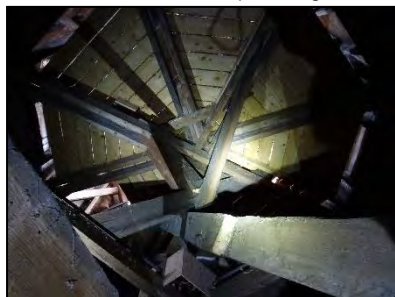
Figuur 16. Constructie toren, zicht op eerste platform met koekoek ramen, vanuit ruimte met klokmechanisme.
