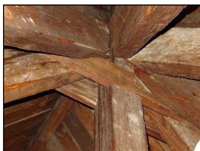
Figuur 22. Detailopname constructie dak.
