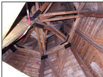
Figuur 19. Constructie spits van de toren.
