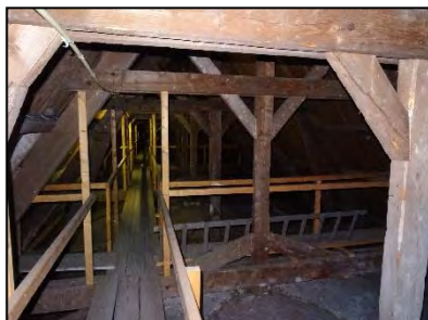
Figuur 20. Constructie dak, boven gewelven.
