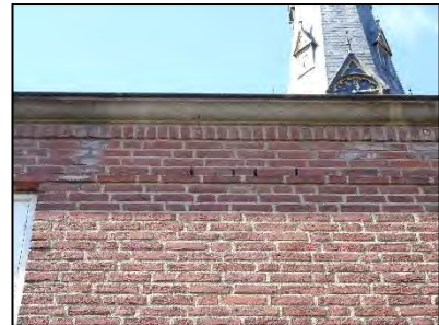
Figuur 27. Detailopname dakrand pastorie met open stootvoegen.
