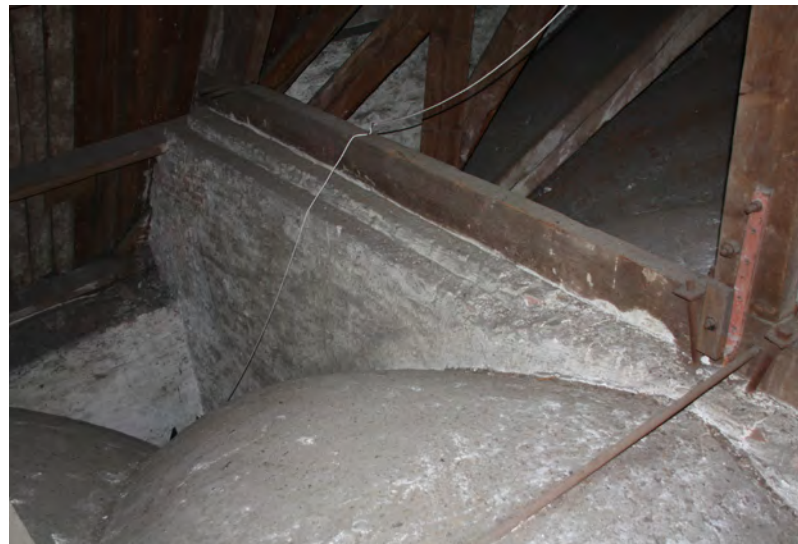
Gemetselde muur tussen het schip en priesterkoor.
