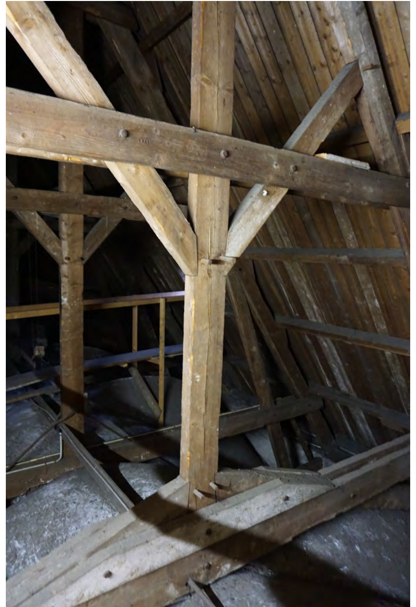
Houten kapsanten boven de metselwerk gewelven van het schip
