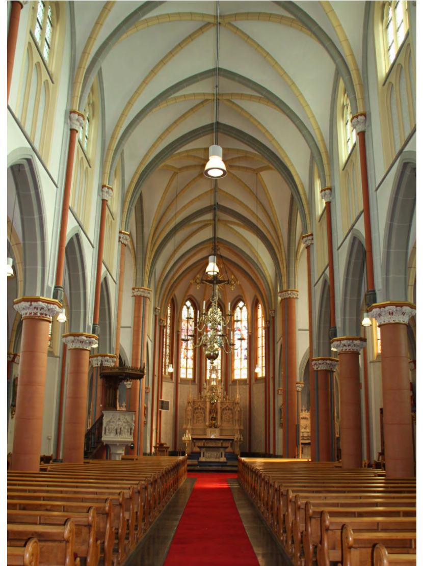
Kruisribgewelven boven de middenbeuk. Boven het priesterkoor is een straalgewelf.
