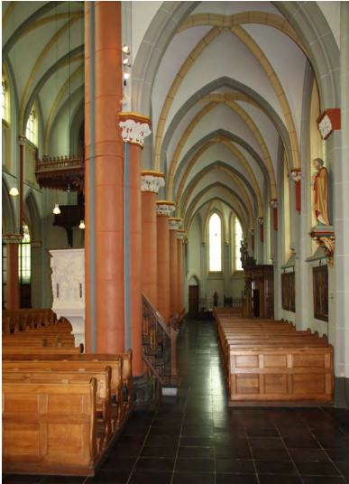
Kruisribgewelven boven de zijbeuk
