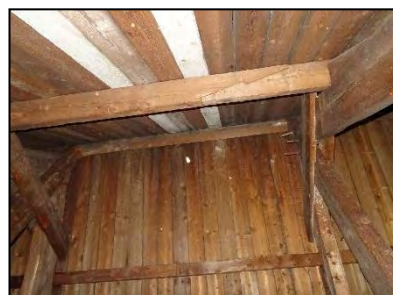
Figuur 21. Constructie dak, lestenen liggen direct op het houten dak dat hier zichtbaar is.
