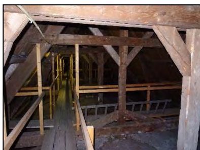
Figuur 20. Constructie dak, boven gewelven.
