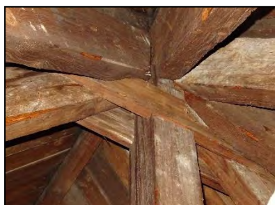
Figuur 22. Detailopname constructie dak.
