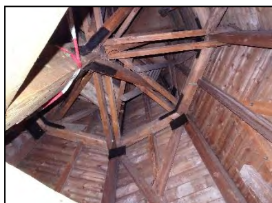
Figuur 19. Constructie spits van de toren.
