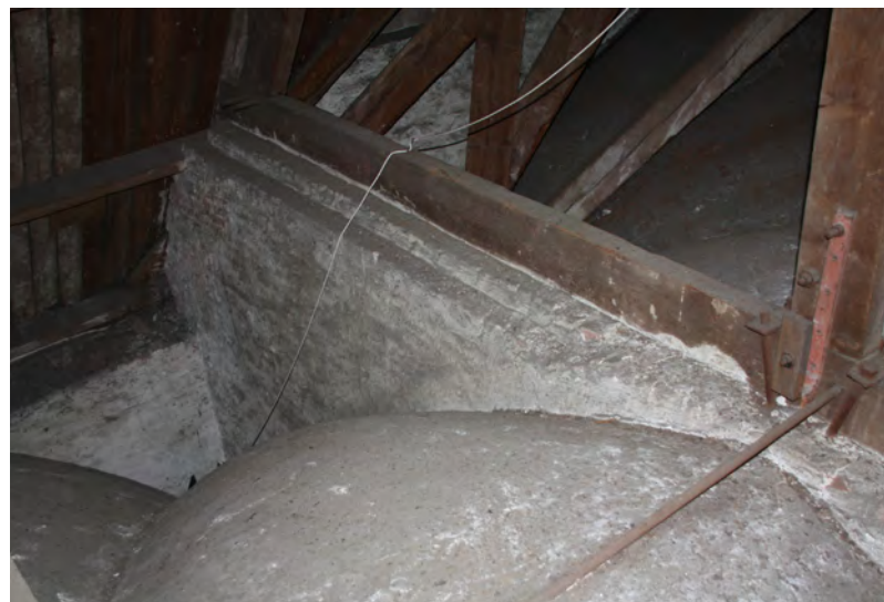
Gemetselde muur tussen het schip en priesterkoor.
