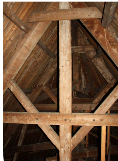
Spanten van de kapconstructie
