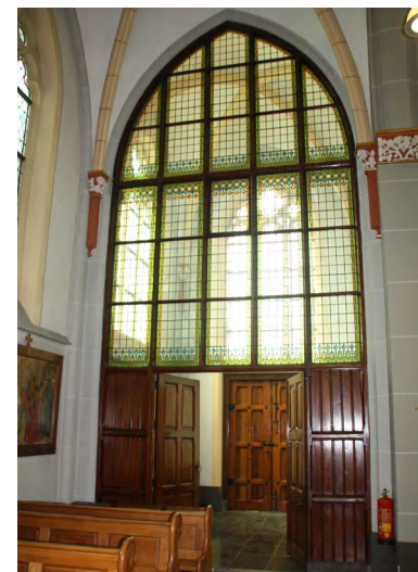
Pui tussen schip en zijportaal
