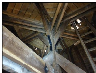
Figuur 18. Constructie toren, zicht op tweede platform met koekoek ramen.
