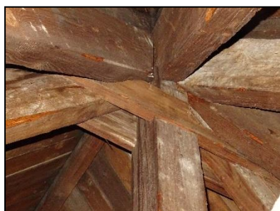
Figuur 22. Detailopname constructie dak.
