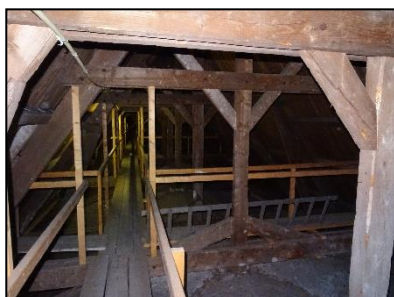
Figuur 20. Constructie dak, boven gewelven.
