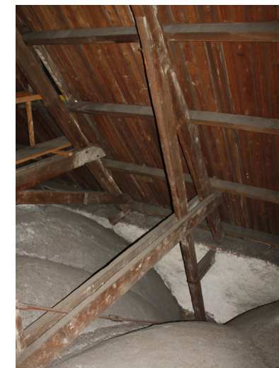
Het spantbeen staat op de muurplaat, de schoor op een zuil.
