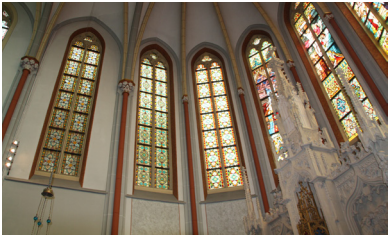
vermoedelijk later aangebrachte ramen
