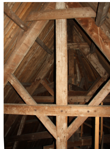
Spanten van de kapconstructie
