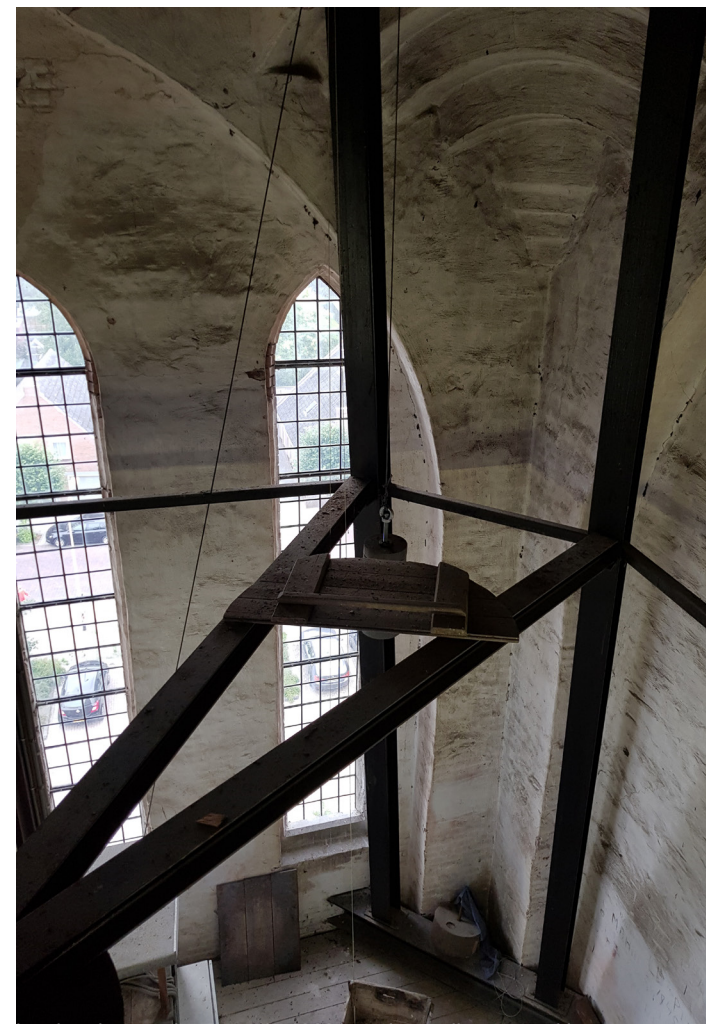
ingebrachte staalconstructie 1983 voor inwendige versterking
