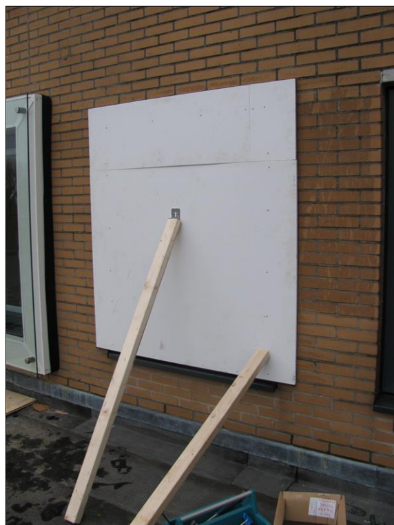
Foto II.4 Provisorische afdichting tweede raam
