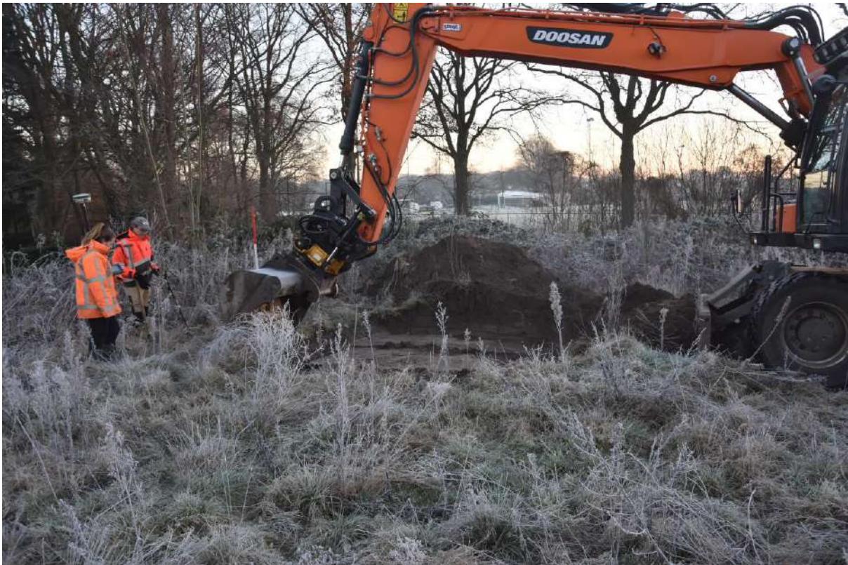
Fig. 1.4. Aalst-Brabantia. Werkzaamheden bij de aanleg van proefsleuf 1.
