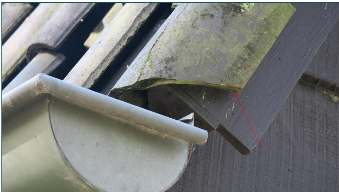
Figuur 3.4 In de woning zijn er kierende kantpannen aanwezig die gebouwbewonende vleermuizen toegang geven naar de ruimte tussen de dakpannen en dakbeschot.
