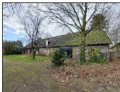
Figuur 4. De zuidzijde van de onderzoekslocatie.
