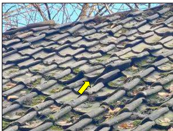
Figuur 14. Ruimtes onder de dakpannen.
