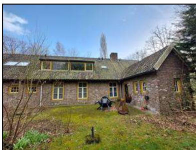
Figuur 6. De noordzijde van de onderzoekslocatie.
