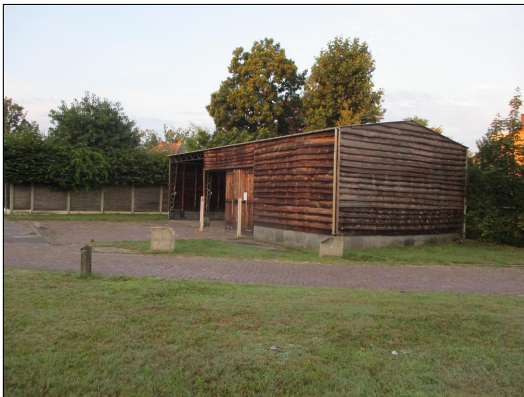
Figuur 2 Schuur A zal worden gesaneerd.
