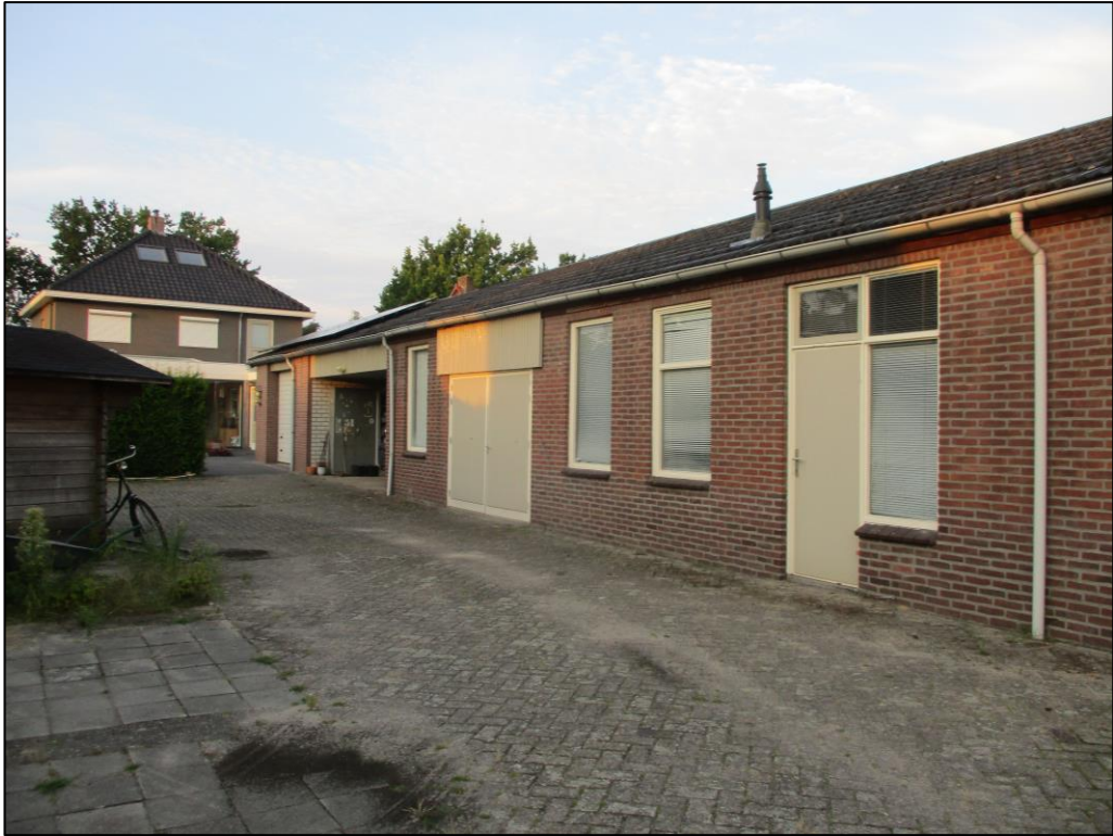
Figuur 3 Autogarage C zal gesaneerd worden.
