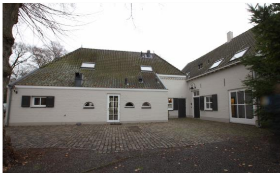
Figuur 5a: Achterzijde koetshuis pand
