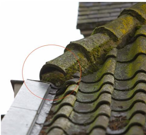
Figuur 5d: Potentiële toegang tot ruimte tussen dakbeschot en pannen.
