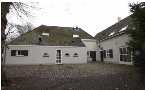
Figuur 5a: Achterzijde koetshuis pand
