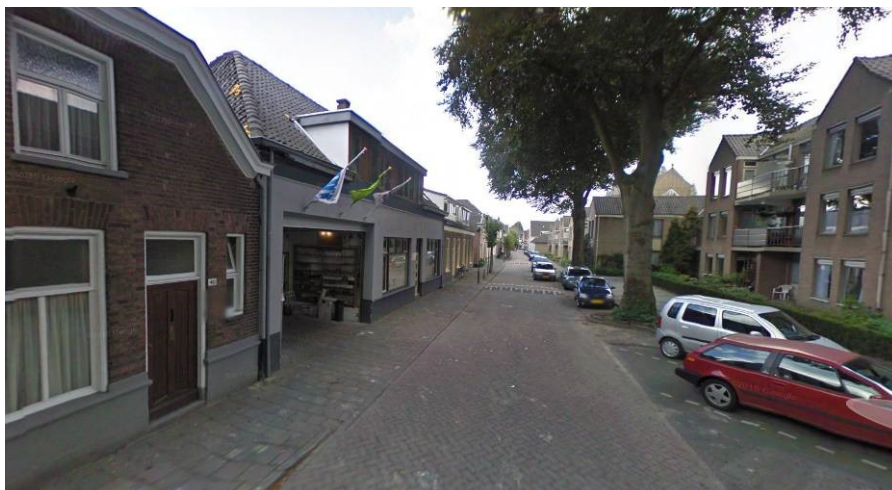
Beeld van de Kerkstraat met het huidige gebouw aan de linkerkant (bron: maps.google.nl )
