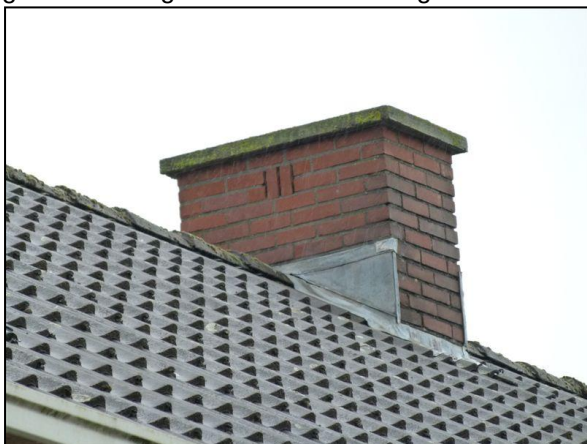
Figuur 13. Openingen schoorsteen.
