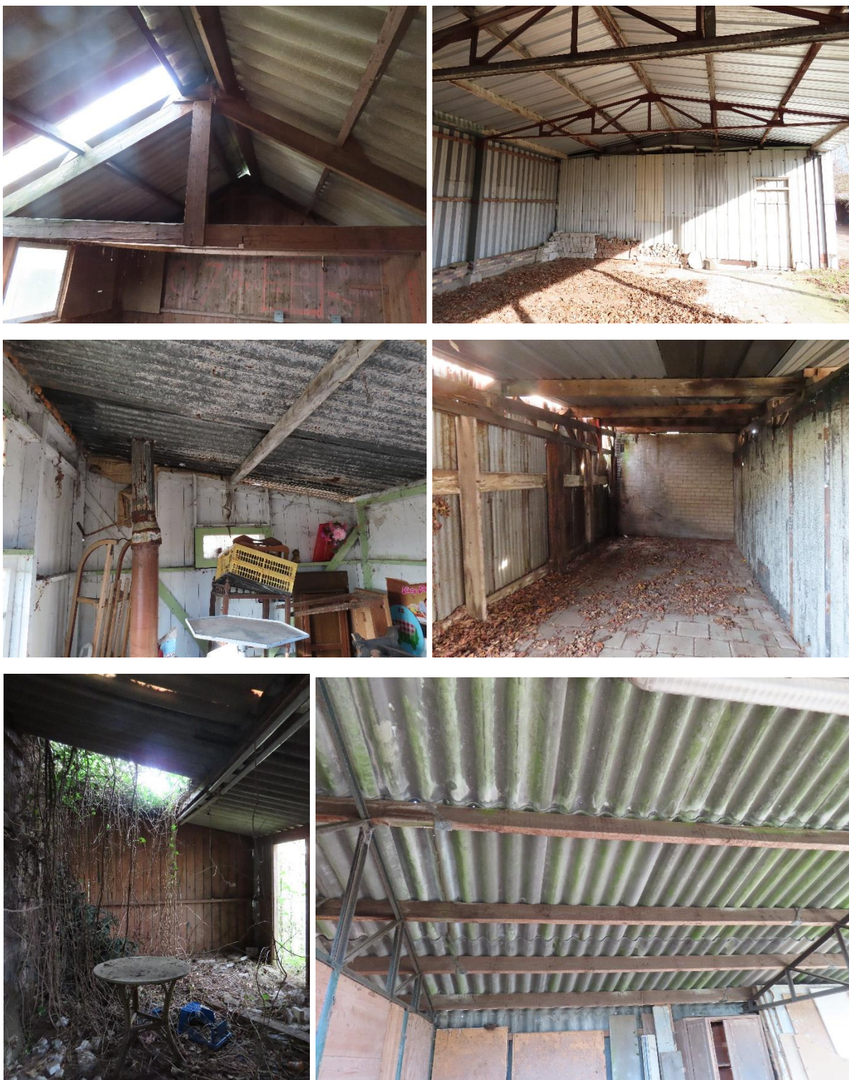
Afbeelding 25 t/m 32: Geen nestlocaties en nesten van de huismus aangetroffen in de te slopen bebouwingen. Bron: BNL advies. Datum: 04-03-2024
