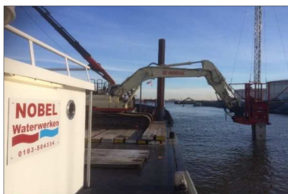
Uitvoeren dieptedetectie t.p.v. de waterbodem
