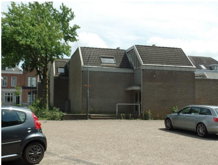
Fig.4. Zicht op achterkant van de bebouwing
