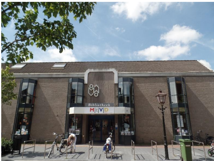
Fig.5. Voorzijde van de bebouwing
