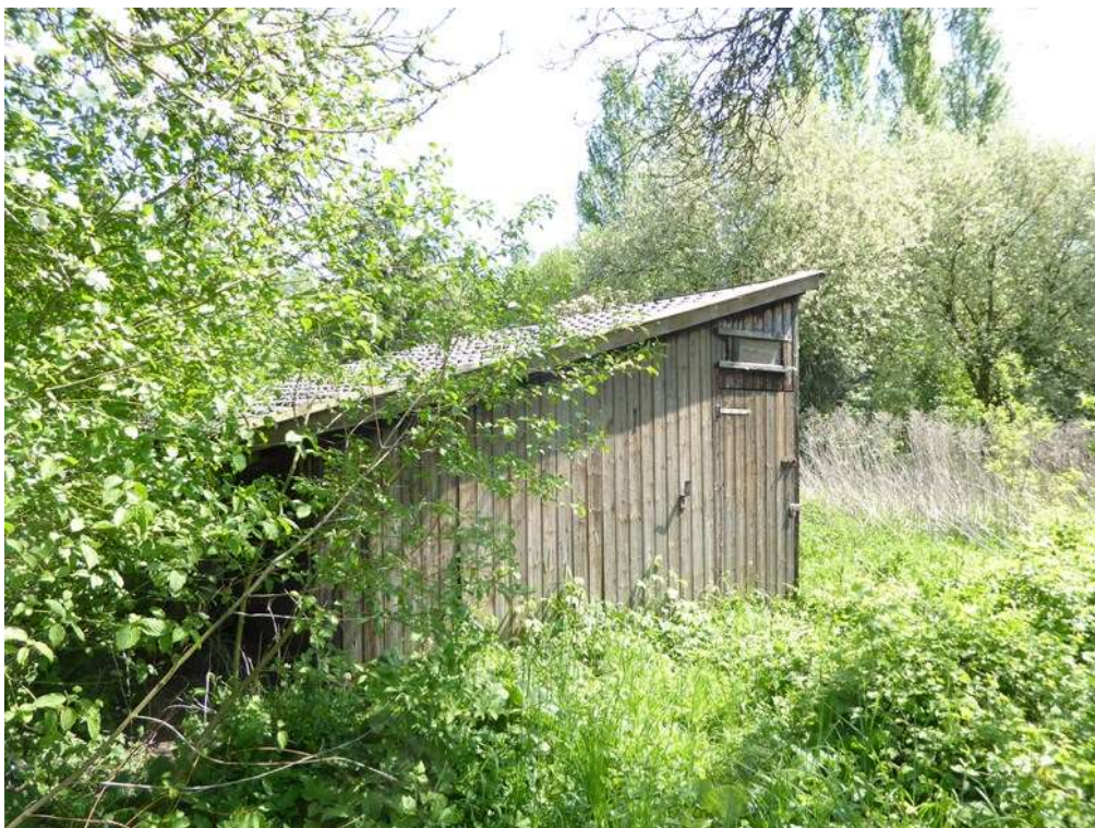
Figuur 4. Schuurtje in het plangebied, met dakbedekking van onder andere dakpannen.
