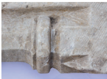
Afb. 3.15 Detailfoto's van een van de natuurstenen ornamenten (vondst 7). Hierop zijn de zaagsporen en de pleisterlaag met resten van beschildering goed zichtbaar. Foto's: G. Oldenmenger.
