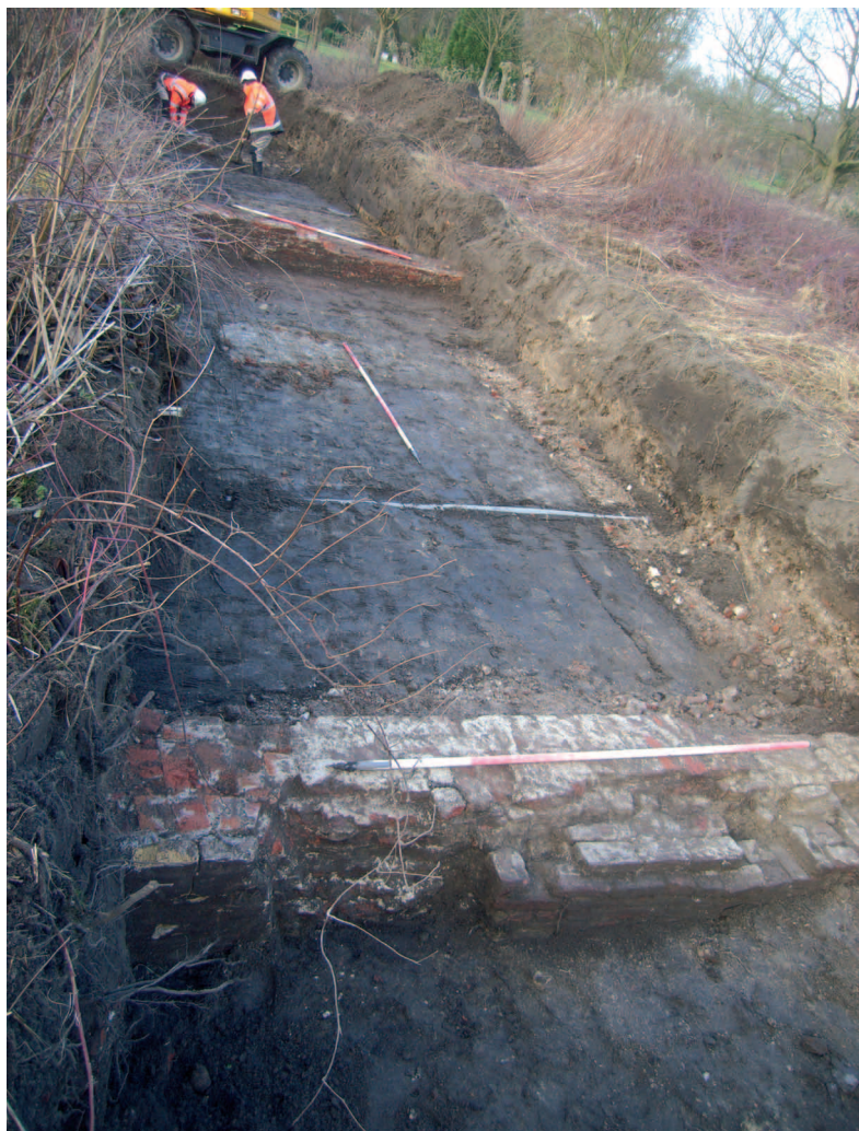
Afb. 3.3 Muurwerk spoor 3004 en uitbraakspoor van muurwerk spoor 3005. Foto genomen in noordwestelijke richting.
