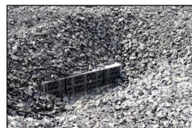
Figuur 5: Permavoid aansluitstuk (kolk)
