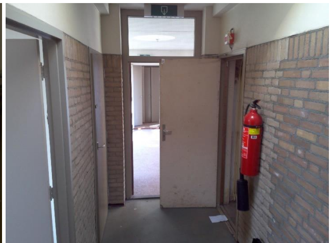
Foto 88 | Foto voor bron Deurbeplating
