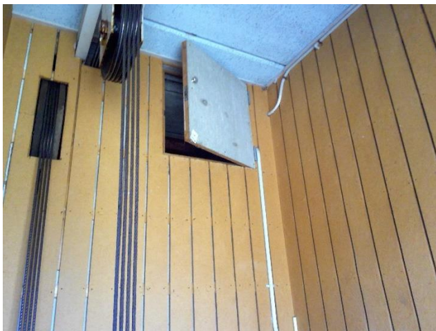
Foto 103 | Foto voor bron Inspectieluik
