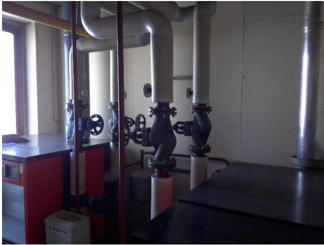
Foto 89 | Foto voor bron Deur- wandbeplating
