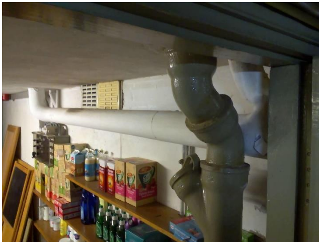
Foto 56 | Foto voor bron Leidingisolatie (Gips)
