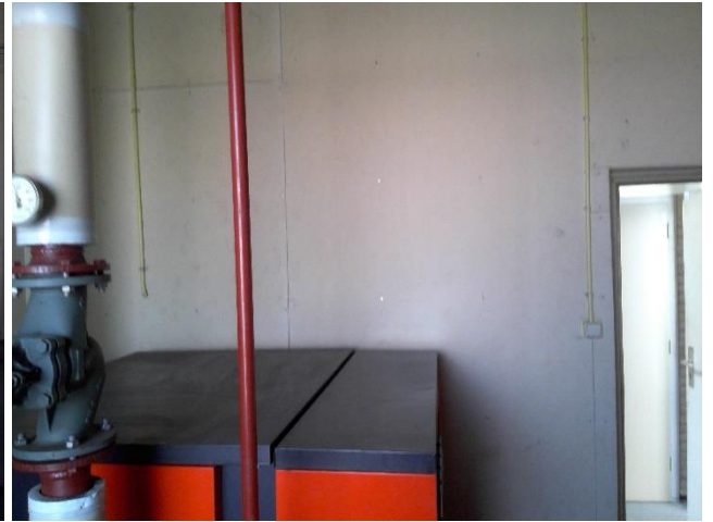
Foto 90 | Foto voor bron Deur- wandbeplating
