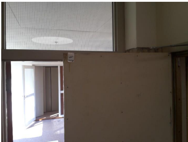
Foto 87 | Foto voor bron Deurbeplating
