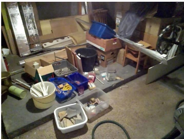
Foto 46 | Foto voor bron Ketelopstort (golfplaat)
