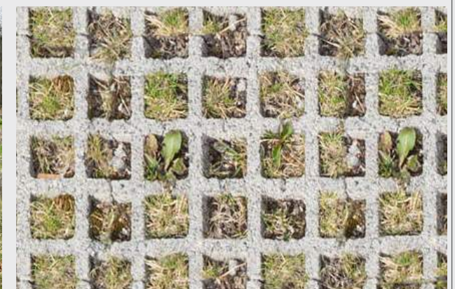
In de parkeervakken komen grasbetontegels te liggen. Inzaaien met soorten van de droge zandgronden of lage kruidensoorten ( kleine klaver of madeliefje)
