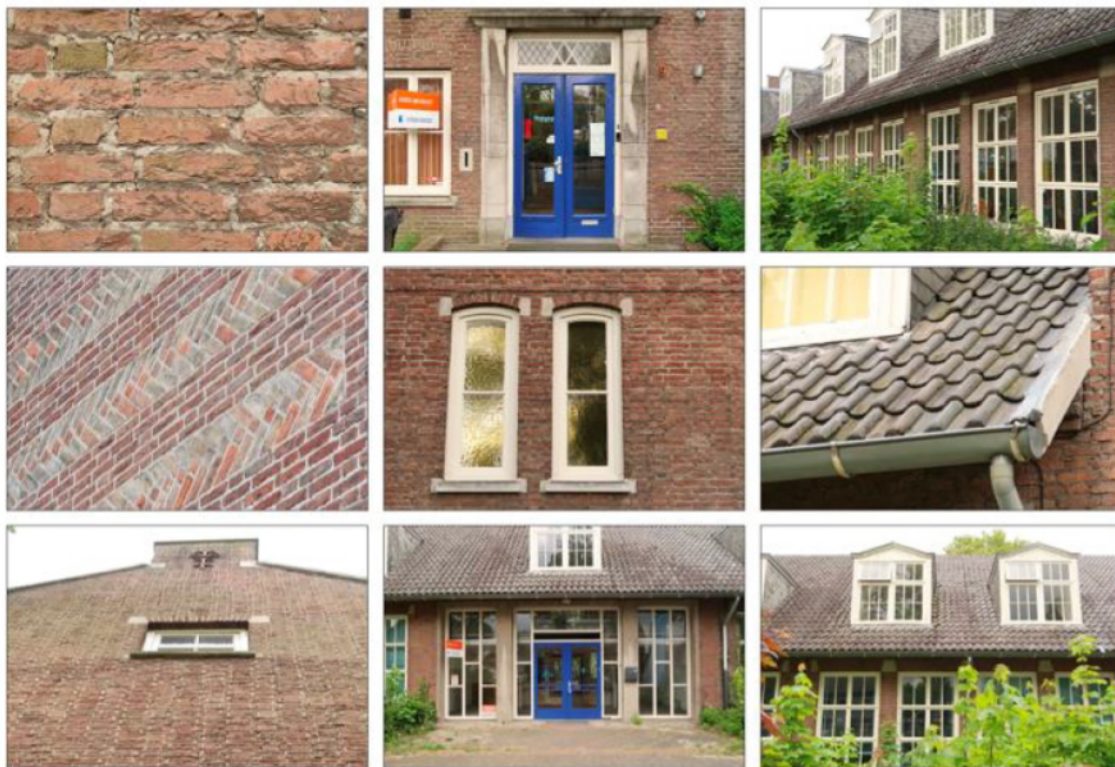
Willibrordusschool: details karakteristiek metselwerk.
